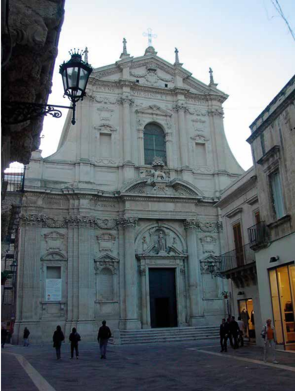
Figura 1: Lecce, chiesa di Sant'Irene, facciata (foto dell'Autore).
